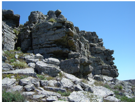
Figura 35: Vista general del reparo o estructura 6 de Curicó.
