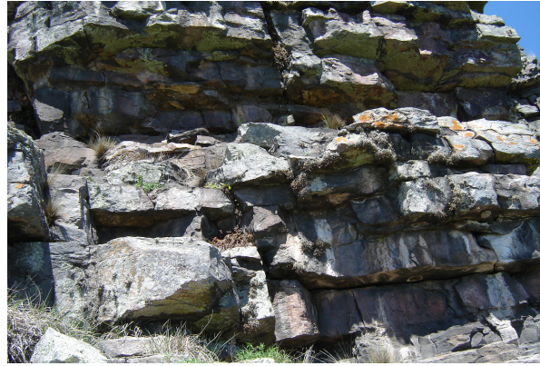
Figura 46: Farallón Curicó con pequeños aleros que no permiten la buena conservación de las pinturas.
